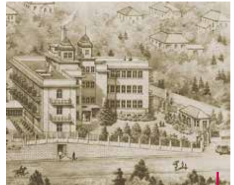
煙突から煙、正門右手に「門衛住宅」
